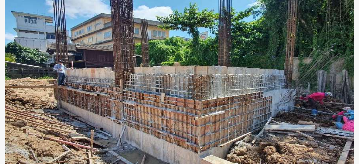
รูปภาพ หล่อถักเก็บน้ำใต้ดิน
