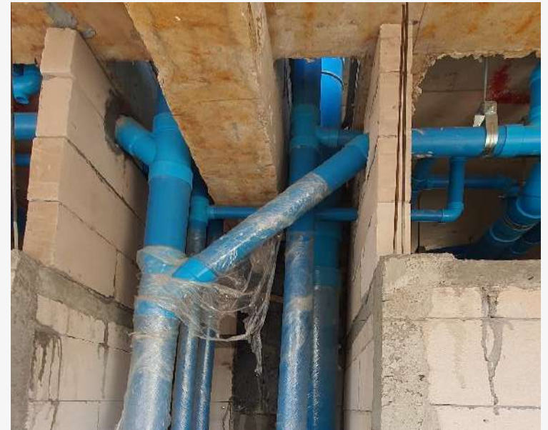
รูปภาพงานท่อระบบสุขาภิบาลชั้นที่ 1
