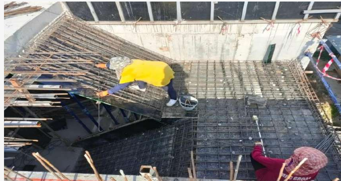
รูปภาพงานวางบันไดชั้นที่ 4
