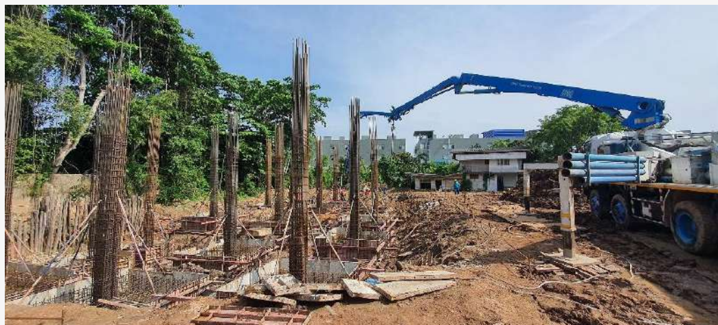
รูปภาพการก่อสร้างฐานราก
