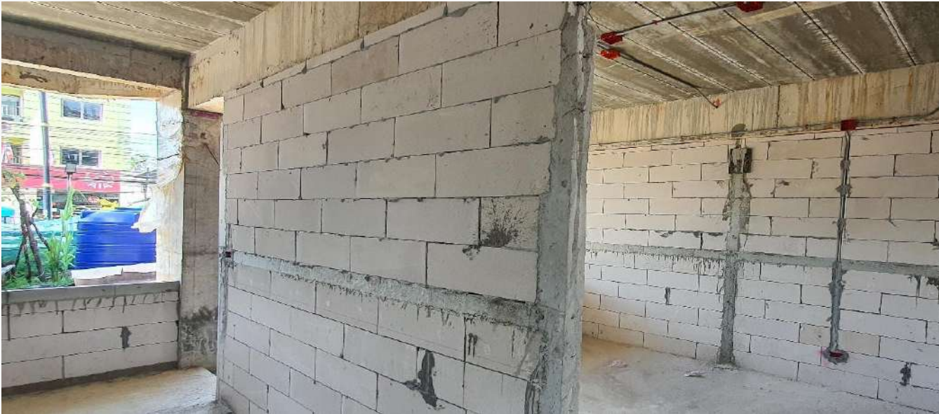
รูปภาพงานก่อผนังชั้นที่ 1
