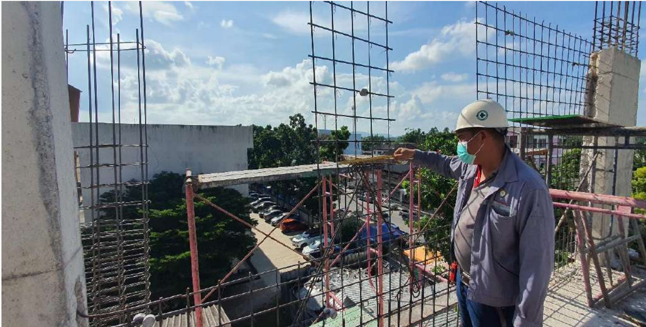
รูปภาพงานเหล็กผนังชั้น 4
