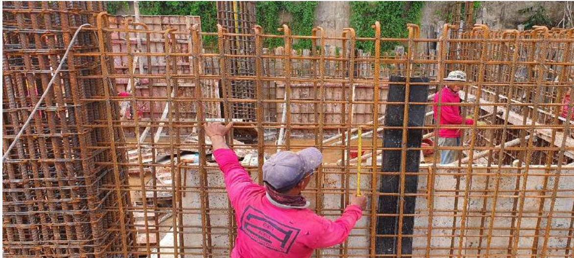
รูปภาพ งานเหล็กถักเก็บน้ำใต้ดิน
